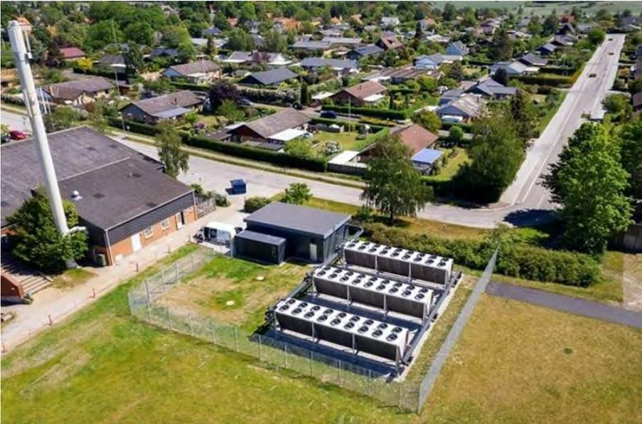
Abbildung 46: 1-MW Luftwärmepumpe in Slagslund Dänemark (Urheber PlanEnergi)
